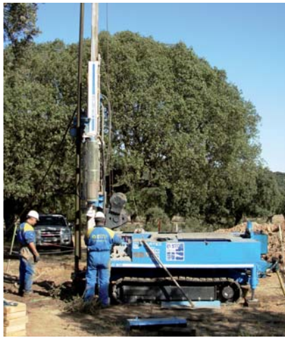
Fotografía N° 1: Perforación de sondeo con HQ
