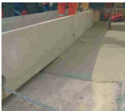
Hormigonado con HAC del andén
